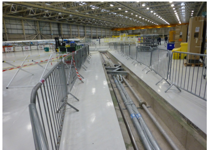
Essensielle serviceledninger som kreves for produksjonsprosessen
